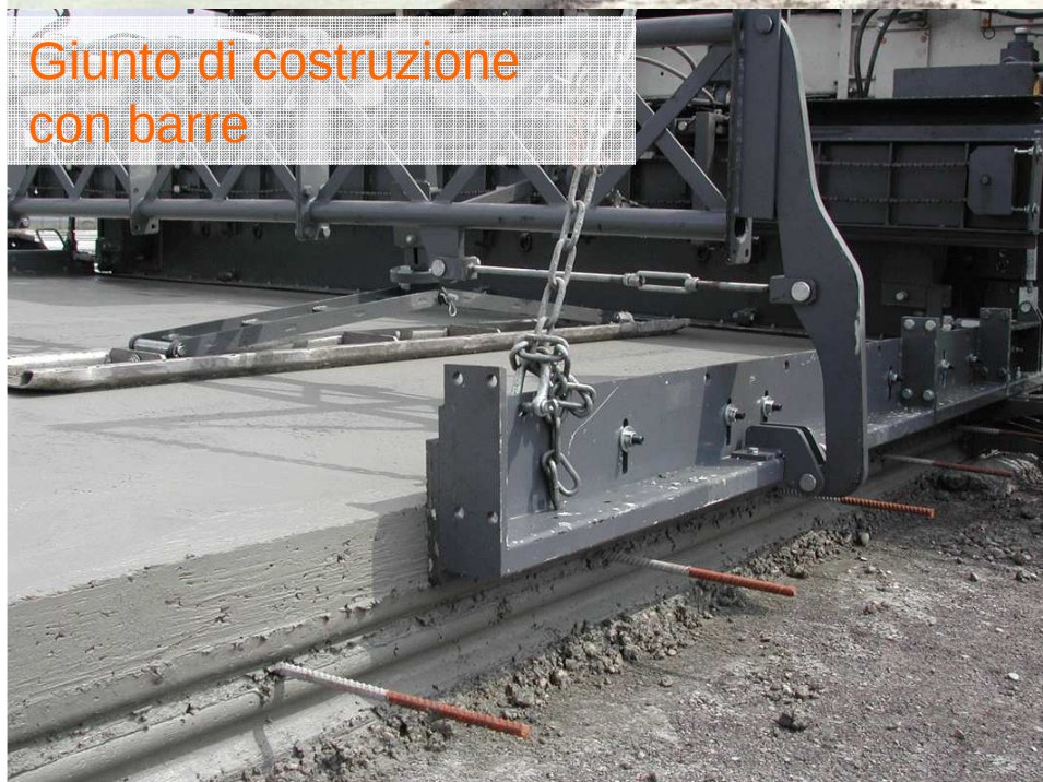
STESA CON MACCHINA A CASSEFORME SCORREVOLI
